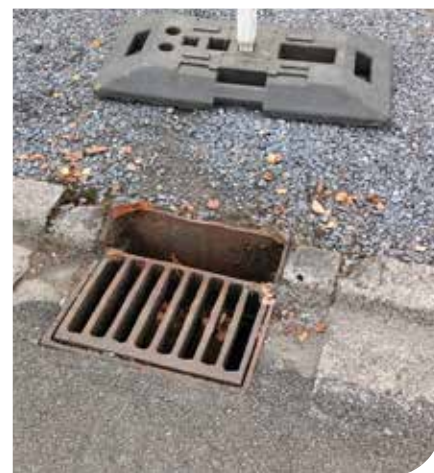
Réparation d'un avaloir
